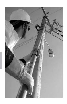
A vara de manobra telescópica seção triangular *RITZGLAS*® tem por objetivo, garantir a distância de segurança e o isolamento necessário nas intervenções em instalações elétricas, sendo portanto uma ferramenta e ao mesmo tempo um equipamento de segurança dos mais usados nesse setor.
